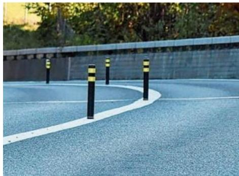
kippar. Alle 20 bis 25 Meter wird auf der Mittellinie ein 65 Zentimeter hoher Poller montiert. In einer zweiten Phase wird dann im Frühjahr 2025 auch die Strecke zwischen Ebnat-Kappel und dem Brendi-Kreisel (westlich Wattwil) mit solchen Pollern ausgestattet.
