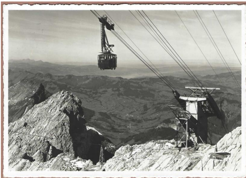
Säntis Schwebbahn Stütze III Gruss nach Siegershausen am 10.7.1938
