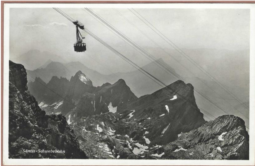
Säntis Schwebbahn Talstation: 1361 m Bergstation: 2483 m Höhendifferenz 1122 m Länge der Bahn 2,170 km Fahrzeit 11 Minuten Kabinenbelastung 35 Pers. Kartengruss nach Basel am 2.9.1935
