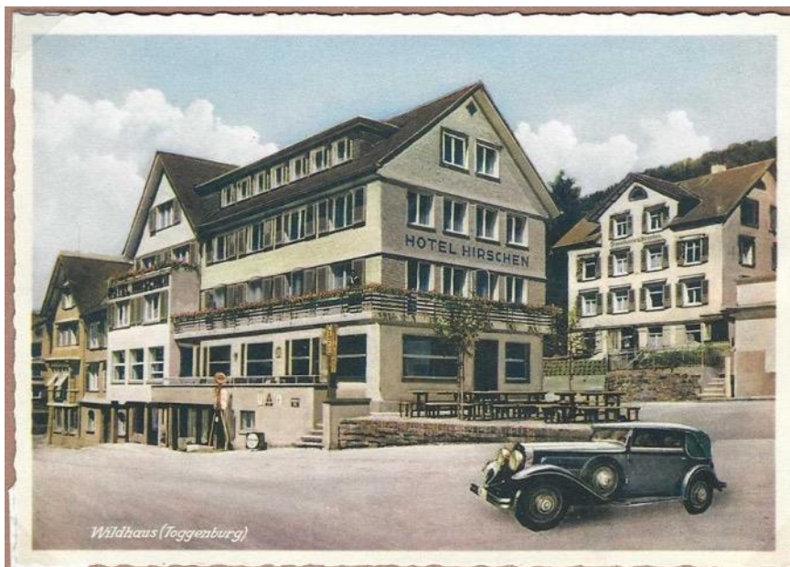
Hotel Hirschen mit Tanksäule
